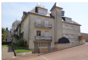
Le bâtiment avant travaux.
