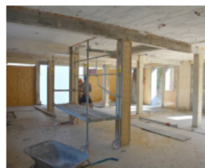
Travaux de restructuration complète.
